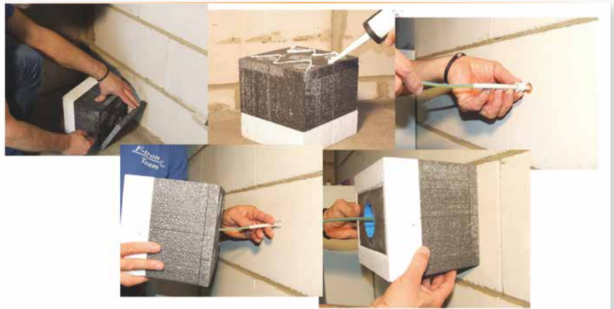
Rys. 5. Przytnij, posmaruj klejem, przeprowadź przewód, dociśnij przez 2 min
